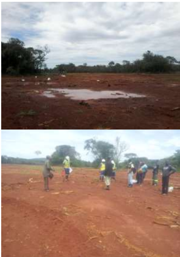
Figure 9 : Réhabilitation du site endommagé (Photo Synergie)
